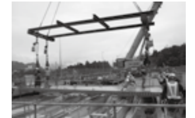
床版取替の様子▶P.18
