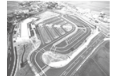
道の駅「めぐみ白山」舗装その2 工事（国土交通省）▶P.15
