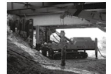
【橋りょう桁下での鋼矢板先行削孔】
