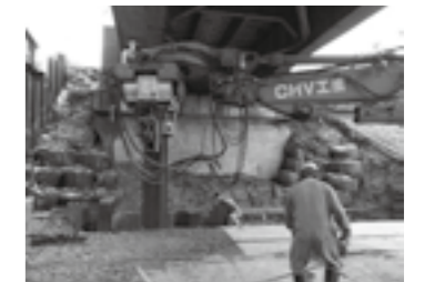
【先行削孔後、鋼矢板打込み】 低空頭MLT工法▶P.19
