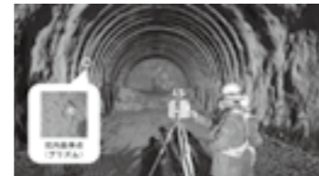
坑内の計測状況▶P.5
